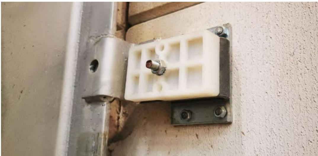
Aux extrémités des murs, des cornières en acier sont fixées mécaniquement aux semelles des poteaux IPE360 (Type 1) permettant aux fixations thermofusibles de remplir leur rôle (voir photo ci-dessous). Dans cette configuration, les dalles de bardage sont en porte-à-faux sur une longueur de 360 mm environ.
