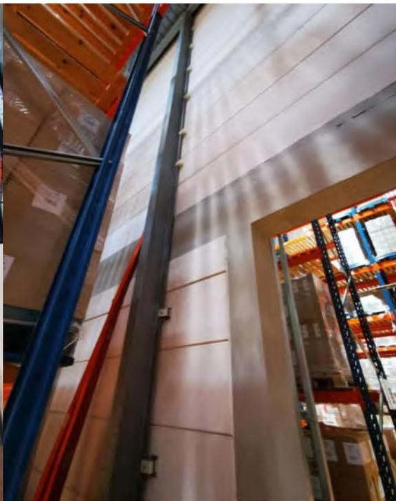
A certains endroits, nous avons pu observer des traversées de tuyaux en acier/acier inoxydable ou plastiques ainsi que des traversées de câbles électriques. Nous n'avons pas pu observer si ces traversées étaient correctement calfeutrées.
