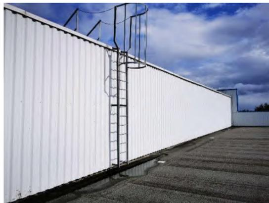
A certains endroits du mur, au niveau des blocs-portes à un vantail coulissant, des poteaux de section 300 x 350 mm et poutres en maçonnerie béton remplacent les poteaux métalliques. MD Construction l'installateur des murs Xella en 2006, nous a confirmé que lors de la présence des poteaux et poutres bétons, la fixation des dalles de bardage en béton cellulaire se fait dans le béton par des fixations KREMO, donc invisible lors de l'expertise.
